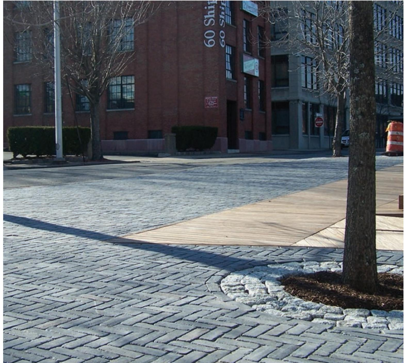
Pavés en béton préfabriqué pour plateau- motif de pose en chevrons
